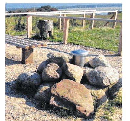
Das Entlüftungsröhr der Trinkwasseranlage. Von der ist sonst kaum etwas sichtbar. Foto: Reinhard Litty
