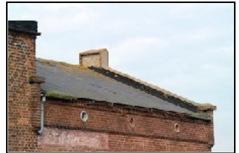
Detail vom Ursprungshaus - klassizistische Elemente an Giebel und Gesims
