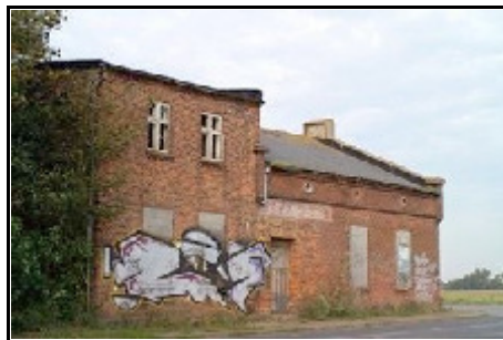
„Haus Büchenschuß“- links Anbau, rechts Ursprungshaus
